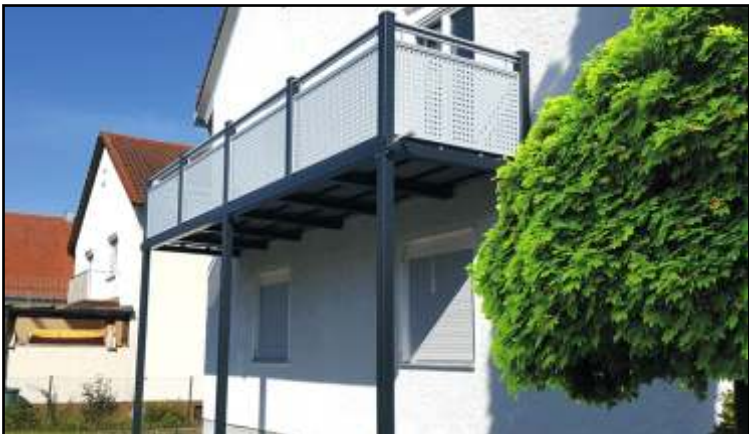
Balkon mit Lochblechgeländer „Quadratlochung“
