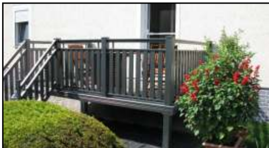
Balkon mit Staketengeländer, Stabbreite 60mm, in Farbe anthrazit-metallic und gerade Treppe
