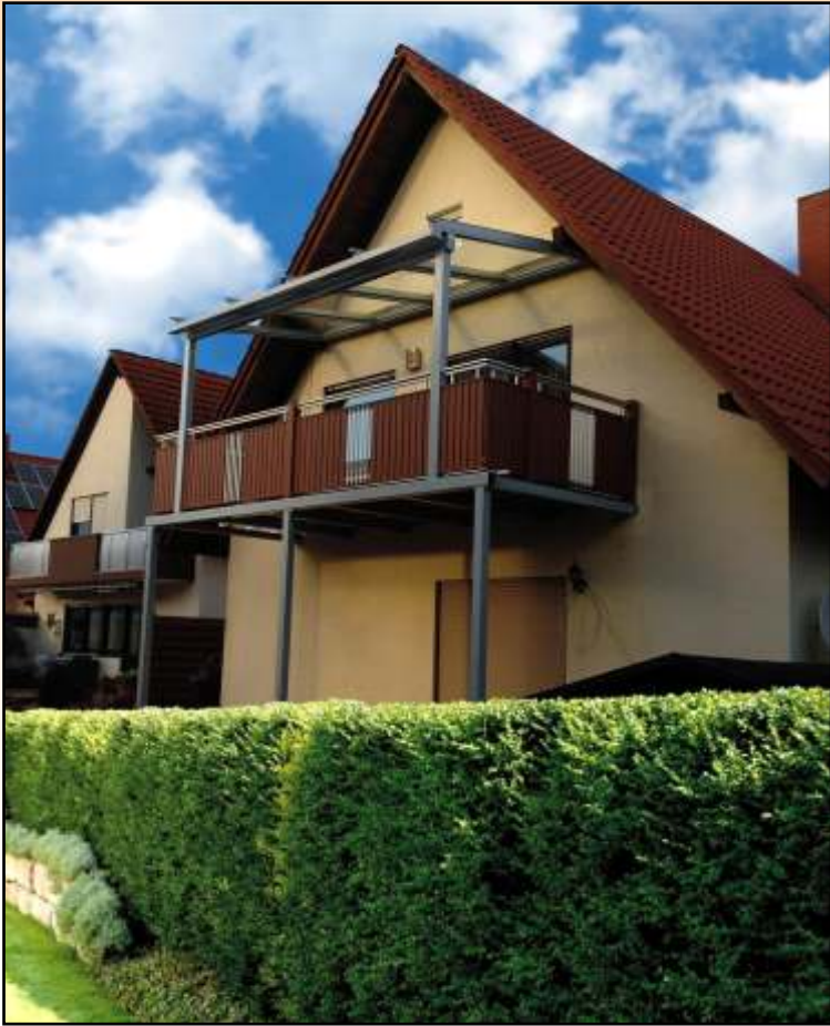
Balkon mit Lattengeländer und Ornament sowie Glas-Überdachung
